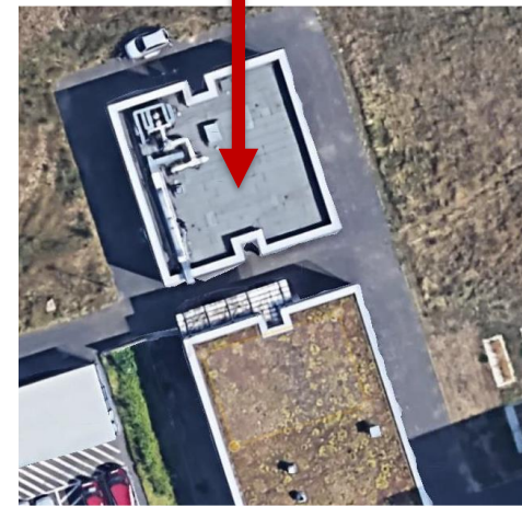
Bitumen roof, Mainz
