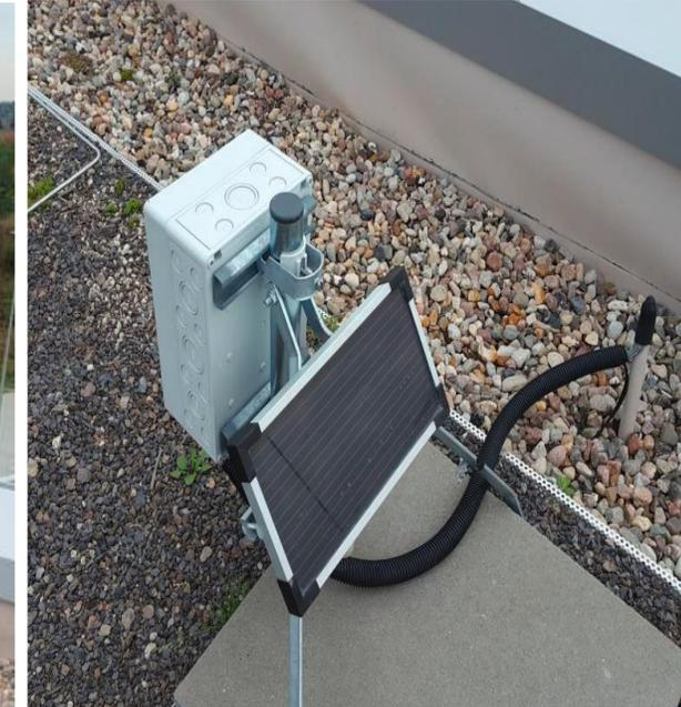
Die Auswerteeinheit kann auf dem Dach oder im Gebäude montiert werden. Sie sendet die Daten an die Cloud-App. Dort werden kritische Zustände erkannt und die Gebäudebesitzer per Mail informiert
