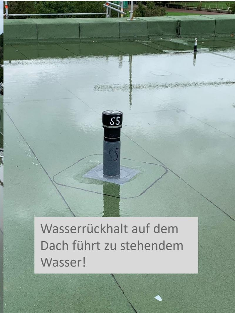
Wasserrückhalt auf dem Dach führt zu stehendem Wasser!
